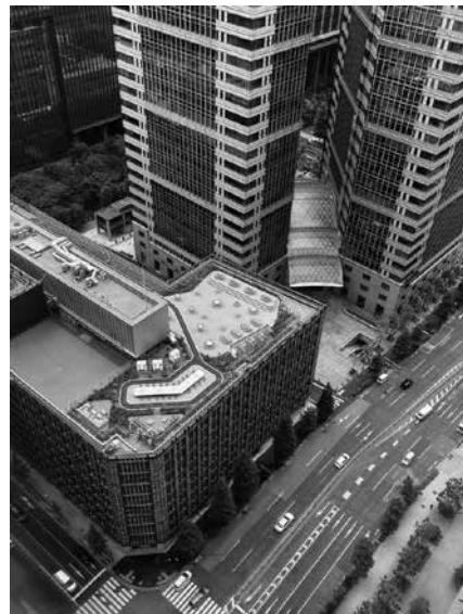
改修後の屋上空地「SKY LAB」(日比谷通り側)
