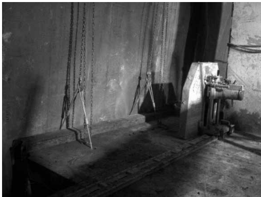
ウォールソウイング工法による跳出スラブ先行切断状況
