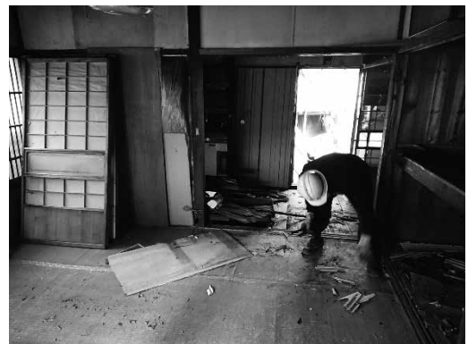
人力による木造家屋解体状況
