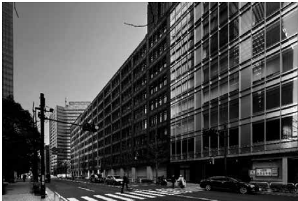
北東面外観を見る
