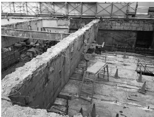
ワイヤーソウイング工法による梁切断状況での打撃と圧砕工法併用解体
