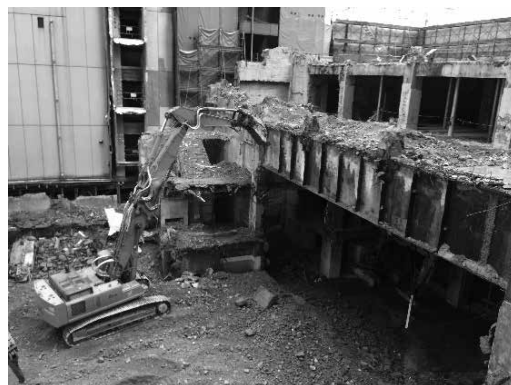
大型重機による圧砕工法による鉄骨切断
