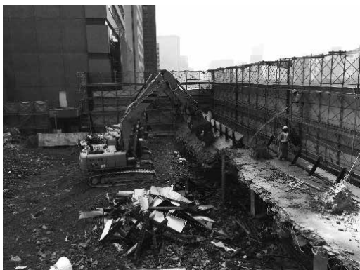
都市型階上解体における圧砕工法
