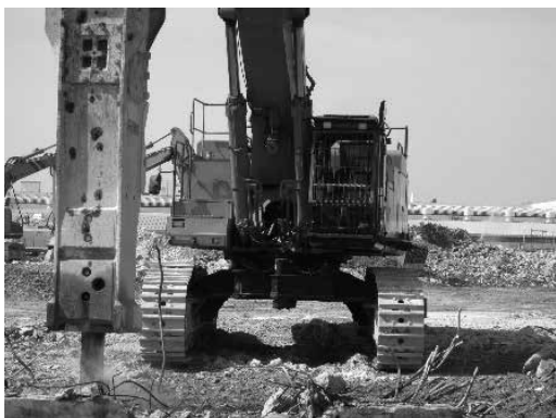
超大型重機による打撃工法
