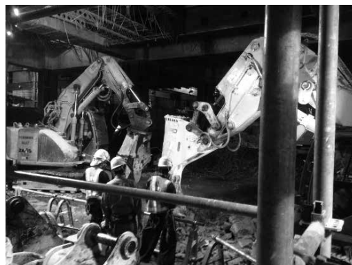
逆打地下解体での打撃と圧砕工法併用解体
