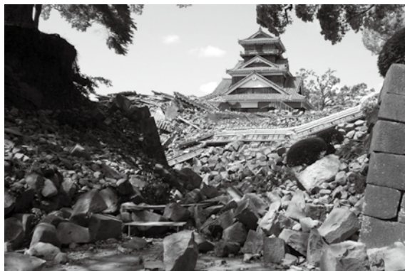
平成28年熊本地震で被災した熊本城
