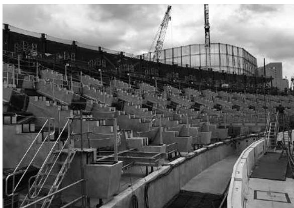
写真9 段床を支えるPCによる斜め梁（レイカー梁）
