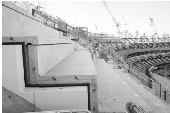
写真10 PCによる観客席の段床（工事中）
