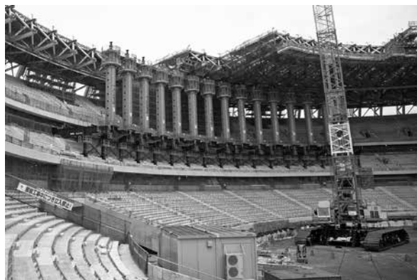
写真 7 大型仮設支保工の架設状況 (工事中)
