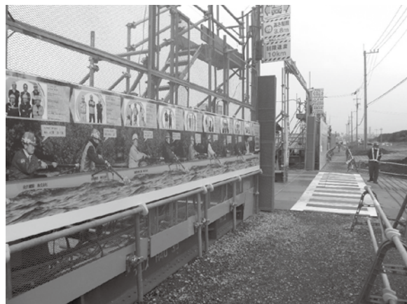
メインゲートに掲示された施工チーム紹介
