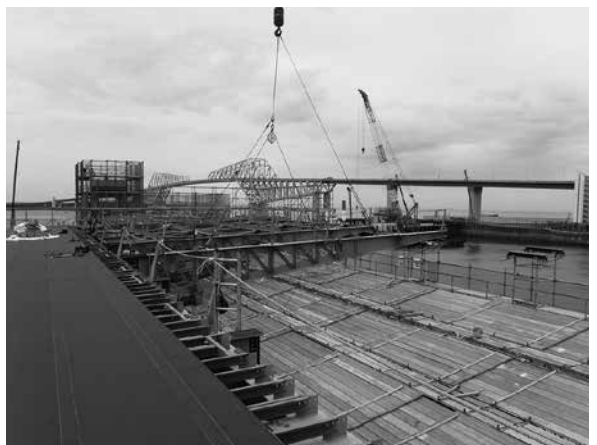
グランドスタンド棟の大庇鉄骨架構状況
