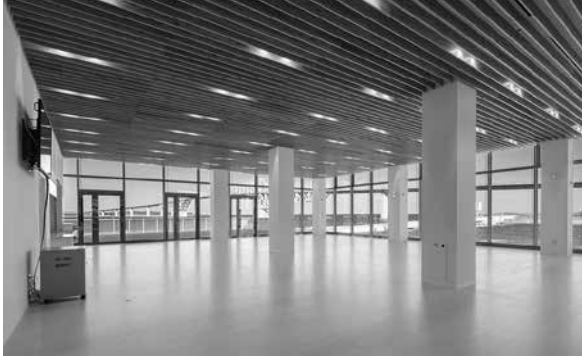
艇庫棟食堂 多摩産杉板天井ルーバー
