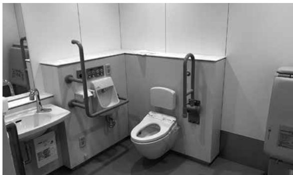
写真6 さまざまな利用者を想定し機能分散した車椅子用トイレ
