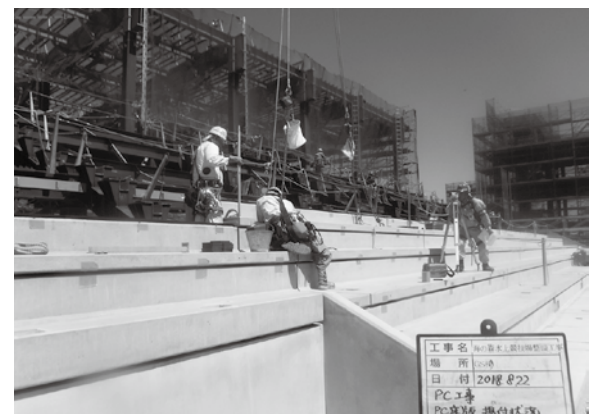
グラウンドスタンド棟の段床 PC 設置状況
