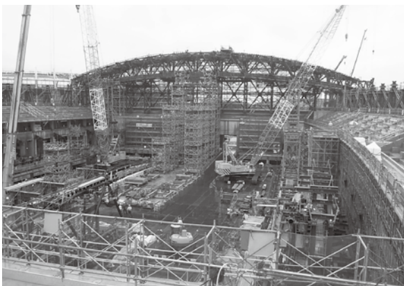
写真5 メインアリーナ棟施工状況
