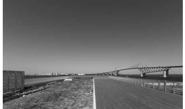
艇庫棟屋上 多摩産杉板を心材とするウッドデッキ
