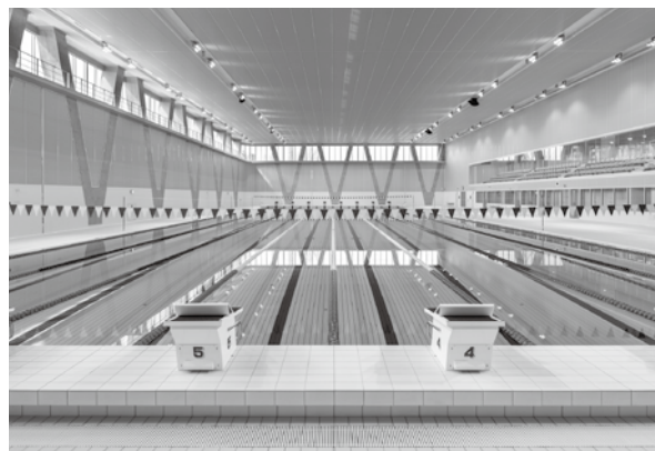
写真4 サブアリーナ・プール棟 プール内観
