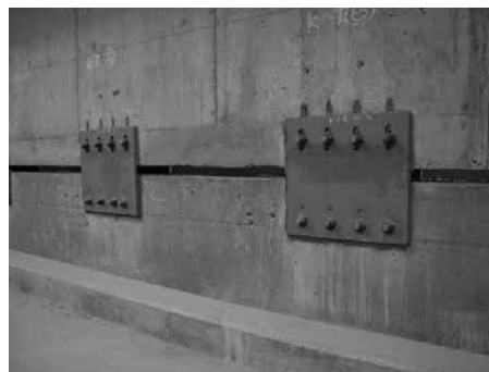
写真3 免震層に鋼製プレートを設置
