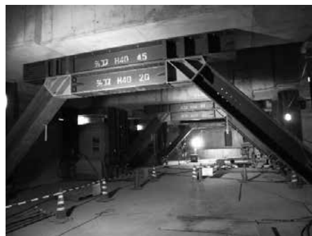
写真2 免震層に鉄骨ブレースを設置
