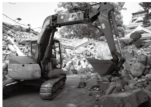
崩落石材回収状況
