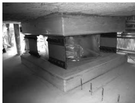
写真4 免震装置周りに鋼製プレートを設置
