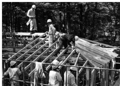
木造建築科 建方実習
