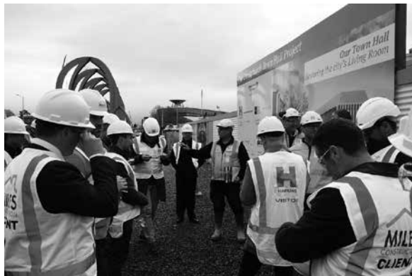
タウンホール現場視察
