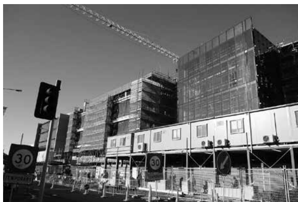
司法庁舎新築現場
