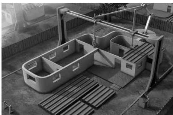
図6 大型3Dプリンタによる住宅建設のイメージ 2)
