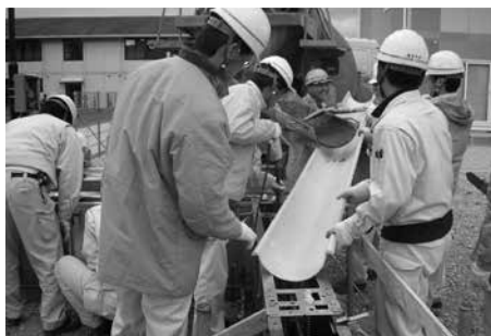
コンクリート 打設
