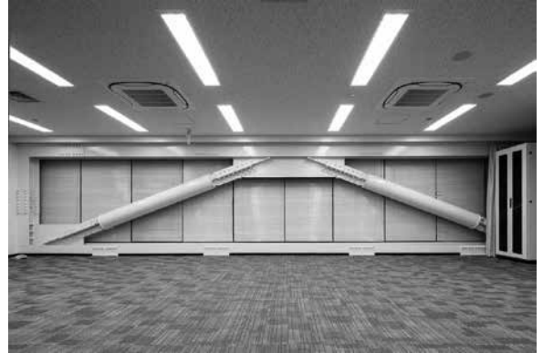
耐震補強 座屈拘束ブレース
