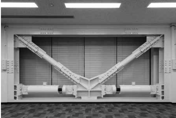
耐震補強 制振ブレース
