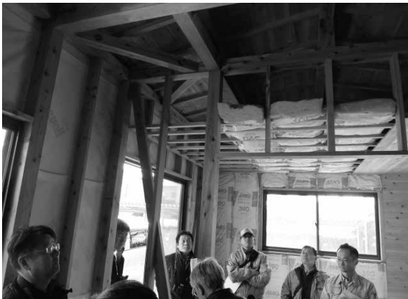
写真1 飯能市製作の仮設住宅
